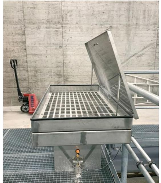
Dosage de la craie au moyen d'un réservoir et d'une vis sans fin
