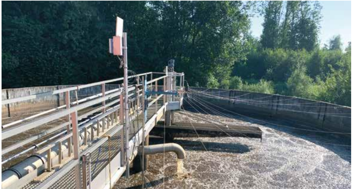
Abb.: Einsatz am SBR Reaktor in Avenches (Schweiz)
