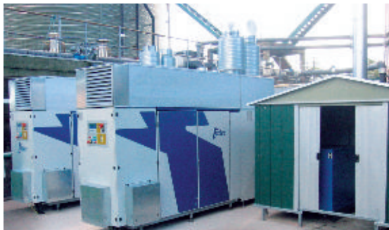
Eprouvée en pratique – la microturbine Turbec T100 série 3 (à l'image: emploi extérieur dans une station d'épuration)
