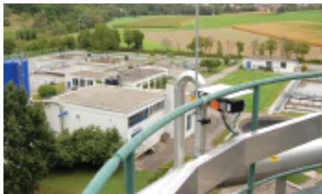
Kläranlage Im Vogelholz. Der Blick vom Faulturm Richtung Gelbingen.
